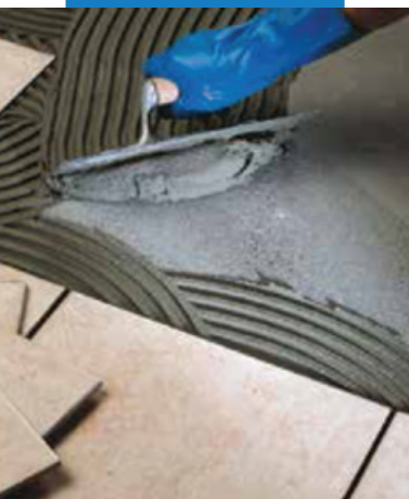
Укладка плитки ординарного обжига на пол
